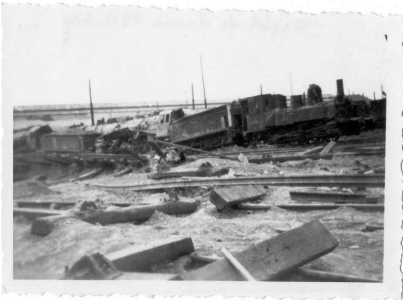
Un train qui a déraillé. Il y a des ruines autour. Il a été détruit par des bombardements.
